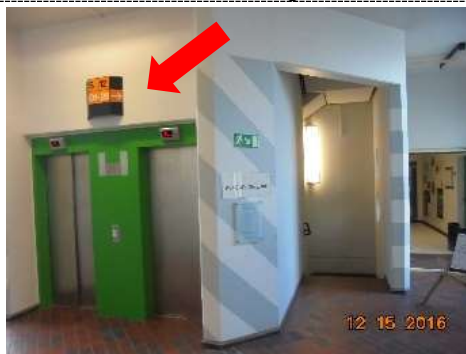
Foto 5.74: asbesthaltiger Bremsbeläge, hier: Beispielfoto
