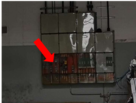
Foto 5.49: NH-Sicherungen, Modul HN, Ebene 06, Quelle: BUW3, Seite 17
