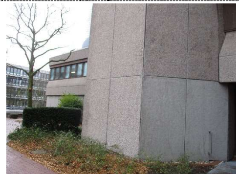
Foto 5.127: PCB-haltige Dichtmasse
