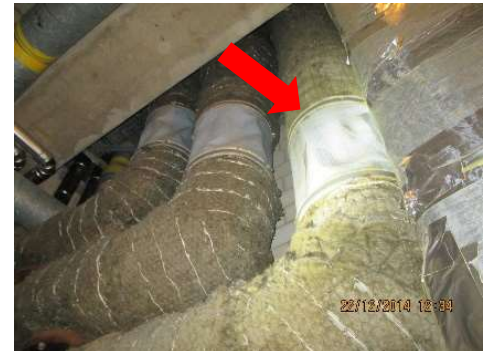
Foto 5.46: asbesthaltiger Dichtstreifen
