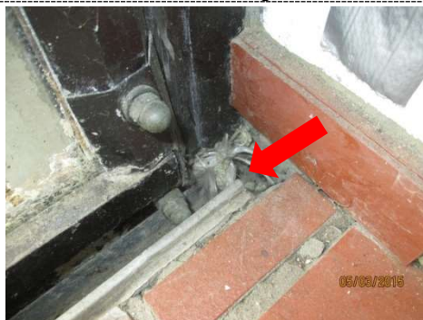
Foto 5.97: Dichtschnur in vertikaler Anschlussfuge der Fensterelemente zum Boden; hier: Modul H, Treppenturm G/H/L, Ebene 9, Quelle: BUW1
