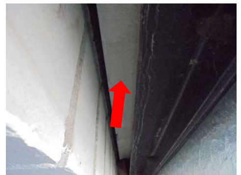
Foto 5.42: Promabest®-Plattenschott als Fassadenanschluss;
