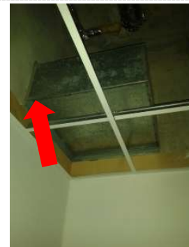
Foto 5.24: asbesthaltige Dichtmassen
