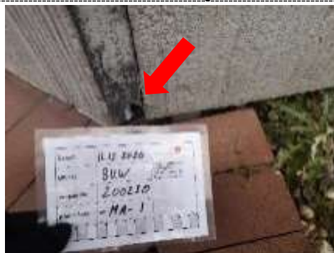
Foto 5.126: PCB-haltige Dichtmasse, Quelle: BUW16
