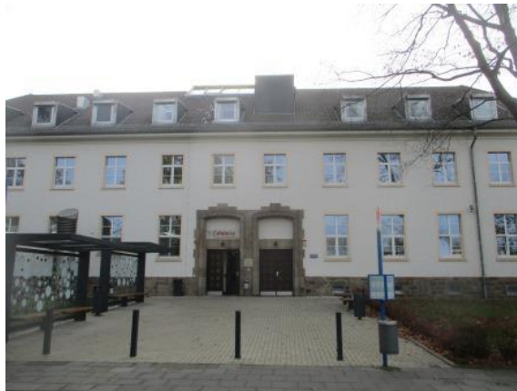
Bild 2.11: Außenansicht, Gebäude FME
