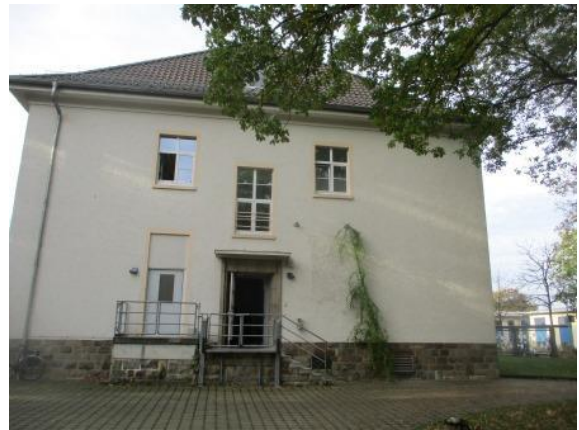
Bild 2.12: Außenansicht, Gebäude FME
