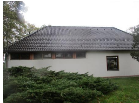
Bild 2.4: Außenansicht, Gebäude FB
