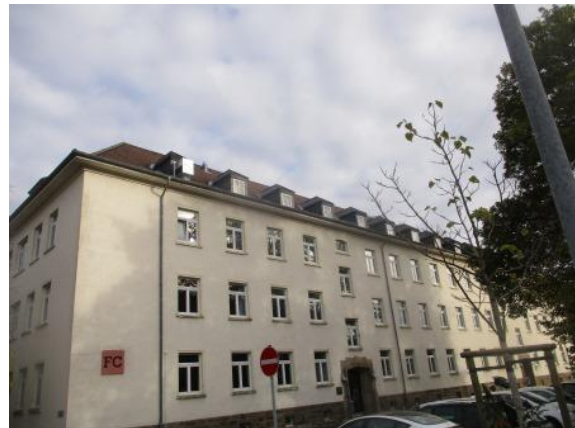
Bild 2.7: Außenansicht, Gebäude FC
