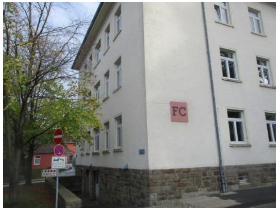
Bild 2.6: Außenansicht, Gebäude FC
