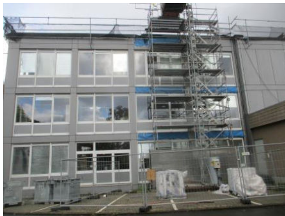
Abb. 3.9: Außenansicht, Gebäude HF
