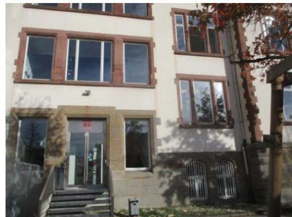
Abb. 3.5: Außenansicht, Gebäude HD
