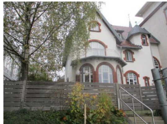
Außenansicht, Gebäude HE
