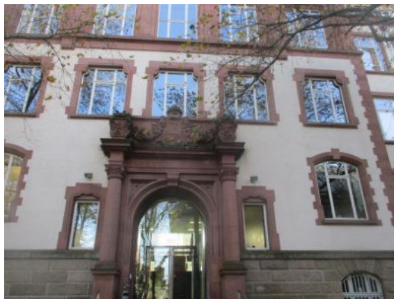
Abb. 3.4: Außenansicht, Gebäude HD
