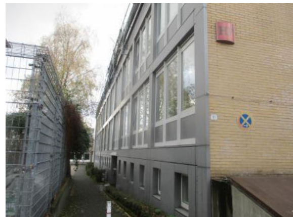
Abb. 3.10: Außenansicht, Gebäude HF
