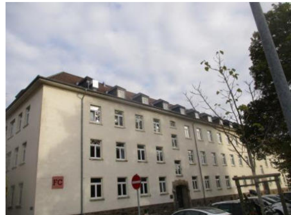
Abb. 3.11: Außenansicht Gebäude FC
