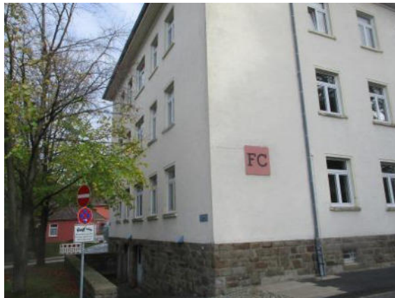
Abb. 3.10: Außenansicht Gebäude FC
