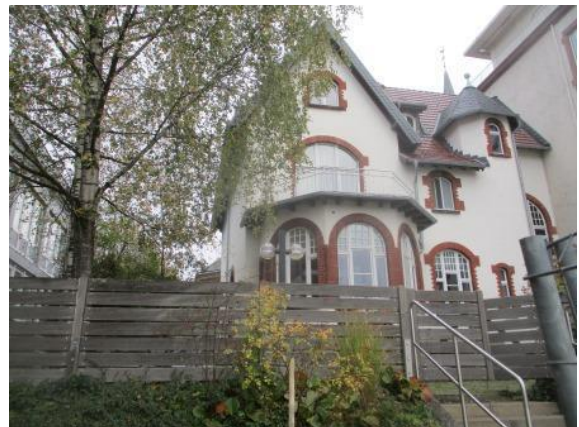
Bild 2.7: Außenansicht, Gebäude HE
