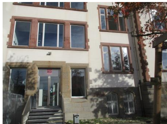
Bild 2.4: Außenansicht, Gebäude HD
