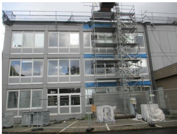
Bild 2.9: Außenansicht, Gebäude HF
