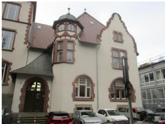
Bild 2.6: Außenansicht, Gebäude HE
