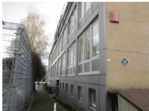
Bild 2.10: Außenansicht, Gebäude HF
