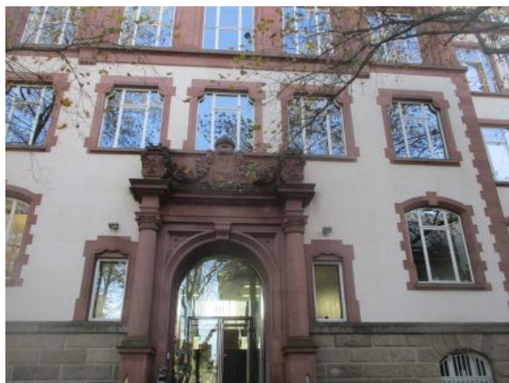
Bild 2.3: Außenansicht, Gebäude HD
