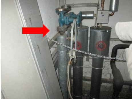
Foto 5.3: Flachdichtung in Flanschen, hier: Gebäude FB, Quelle: BUW1, Seite 33
