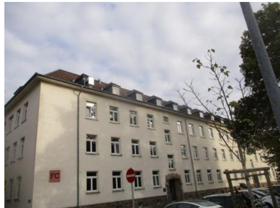
Bild 2.7: Außenansicht, Gebäude FC
