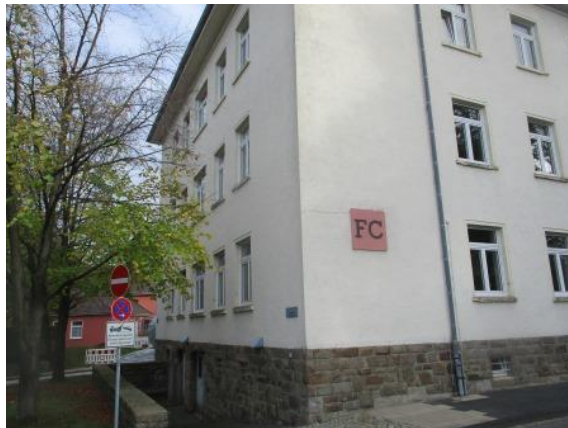
Bild 2.6: Außenansicht, Gebäude FC
