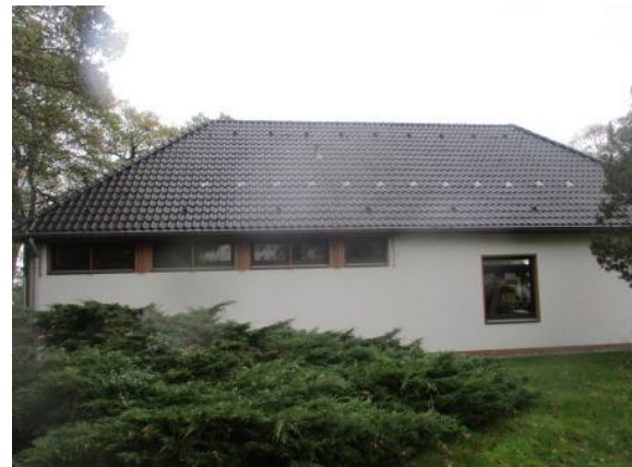
Bild 2.4: Außenansicht, Gebäude FB
